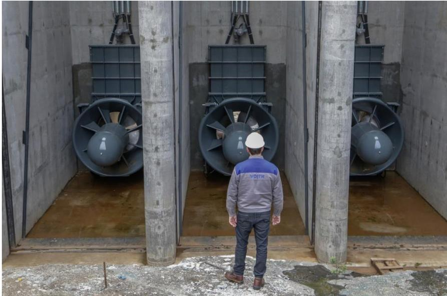
Ilustración 43 – Tabiques Aguas debajo de la central, con guías para compuertas y rejas.
