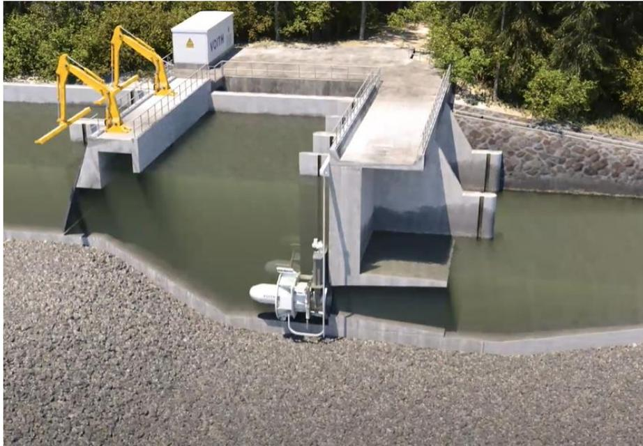
*Ilustración 30 - Esquema típico de central con variante Stream Diver*
